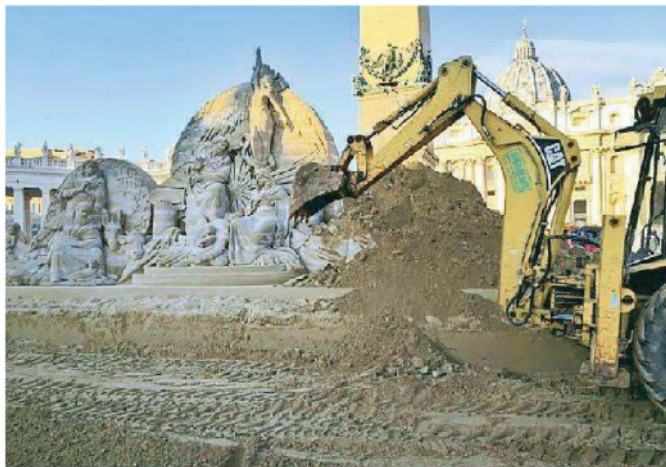
Le ruspe in azione per demolire la stupenda opera in sabbia
